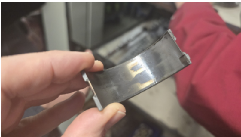
Der befürchtete Schaden , wie in der Safety Publication beschrieben
