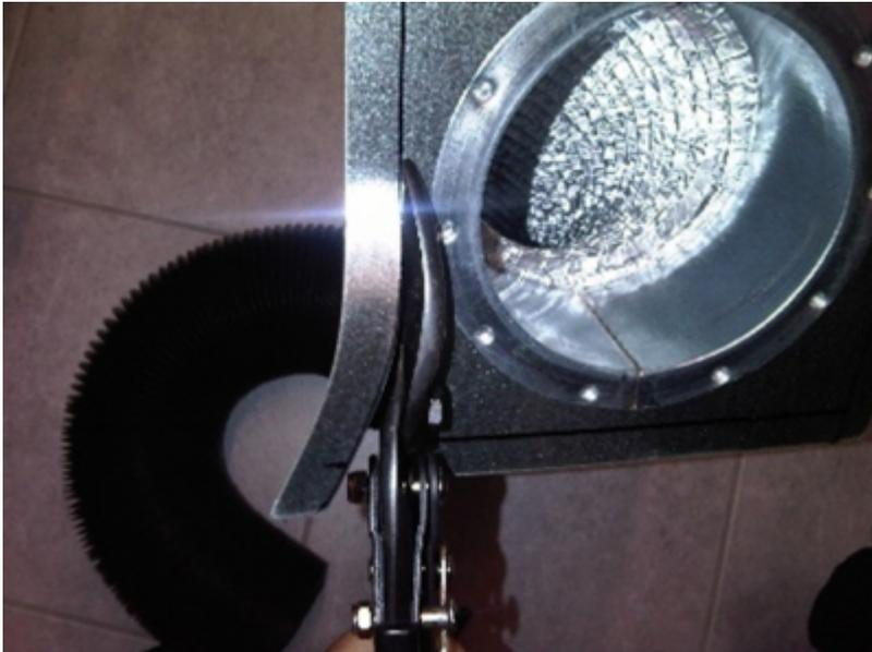
3. Frontplatte mit Blechschere zuschneiden 10cm Öffnung für Wandflansch
